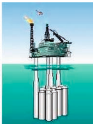
Obr. 1 Sleipnerova plošina – celkový pohled Obr. 1 Sleipnerova plošina – celkový pohled
