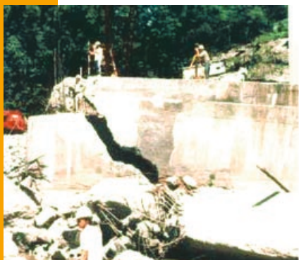
Obr. 19 Most přes Schoharie Creek Obr. 19 Most přes Schoharie Creek
